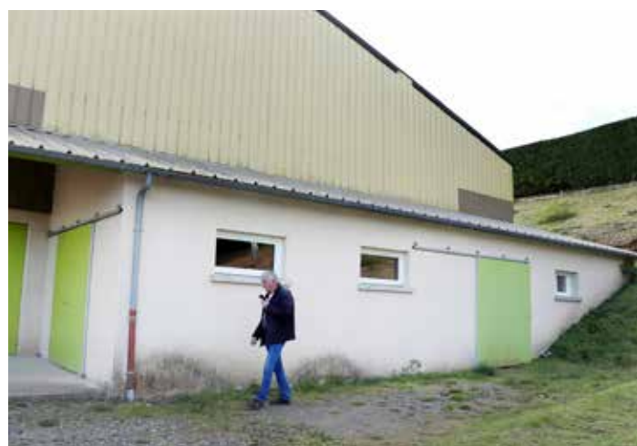
LE LOCAL DE CHASSE - Accolé à la salle multi-activités, il est géré par l'association locale de chasse qui souhaite l'agrandir et utilisera pour cela un local de stockage voisin que la mairie a décidé de mettre à sa disposition.
