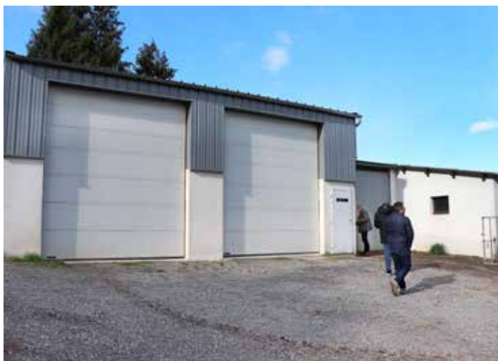
LES LOCAUX TECHNIQUES - Situés à proximité du terrain de foot, ils abritent le matériel de la commune (tracteur, remorque, épareuse, chasse-neige, outils...).
